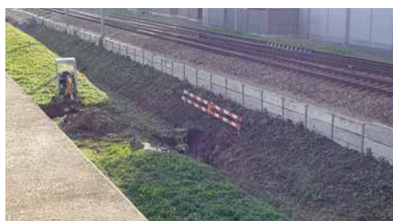
Leitungsverfüllung mit RFB unter SBB Trasse Strecke Luzern – Olten
