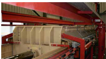
Schlammpresse zur Herstellung des Rohmaterials für REB / RFB
